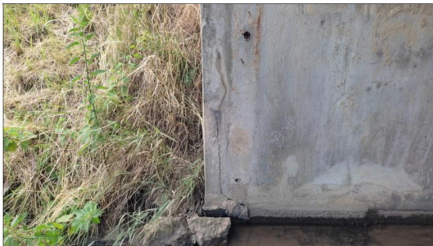
Svislá trhlina v rohu na pravé straně opěry OP1
