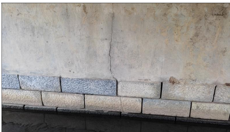
Detail svislé trhliny uprostřed na OP2
