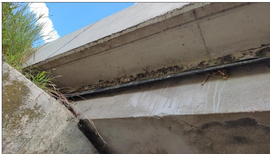
Detail na římsu a ukončení izolace NK
