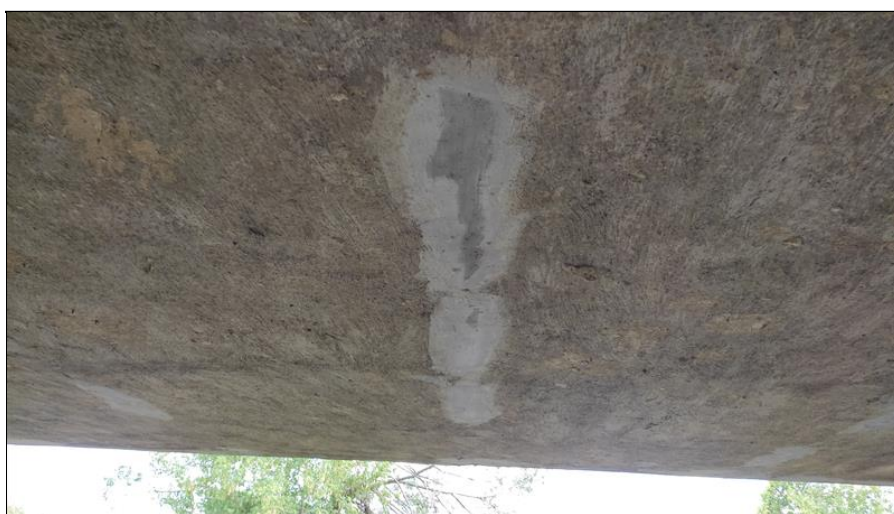
Detail zapravení výztuže na pohledu NK
