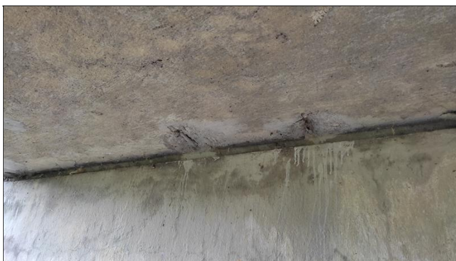
Detail nekvalitně zapravené sondy na podhledu
