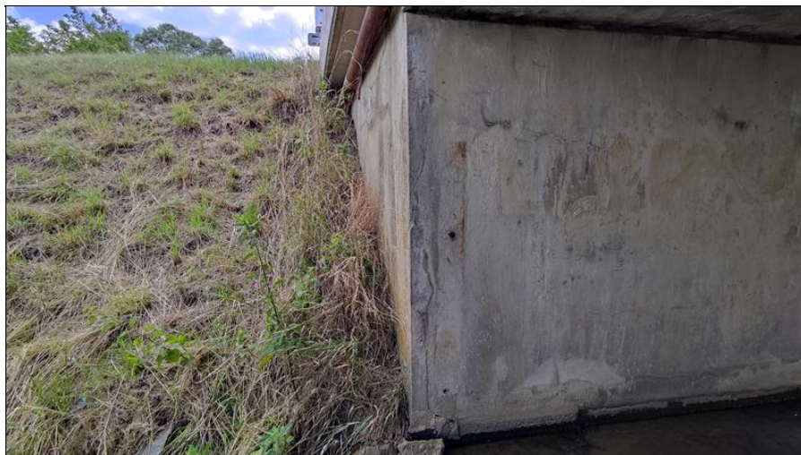
Svislá trhlinka v rohu na pravé straně opěry OP1
