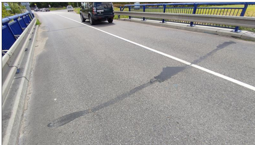
Detail řezané spáry na vozovce nad mostním závěrem
