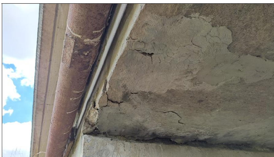
Detail popraskané omítky na levé straně NK
