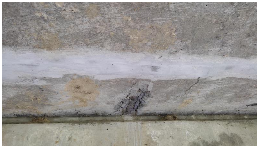
Detail pohledu NK - nezapravená sonda
